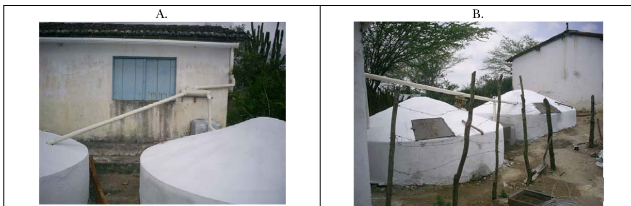
Figura 5 – Dispositivos de tomada de água: A. escola rural; B. vila de casas conjugadas. Fotos ilustrativas de ambos os dispositivos instalados em campo são apresentadas nas Figuras 5 a (Escola Municipal - vasos comunicantes) e 5B (vila de casas conjugadas - fecho hídrico).
