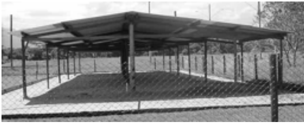
Figura 4 – Lote convencional (75% impermeabilizado) na Riviera São Lourenço – Bertioga – SP.
