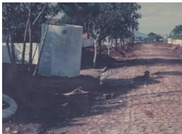
Figura 1 - Execução da rede coletora
