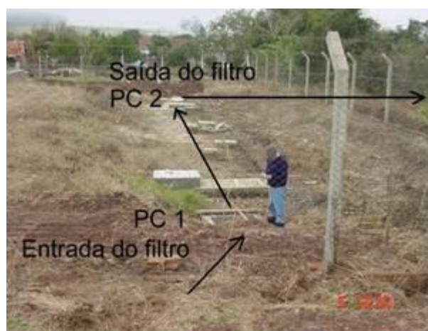
Figura 5 - Pontos de controle na ETE
