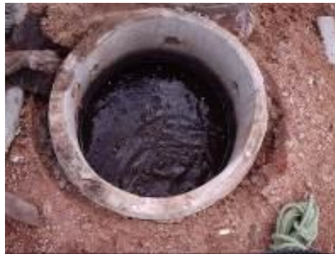
Figura 1. Drenagem de gás completamente tomado por chorume do ASMOC. Fonte: Carvalho Jr, F.H.(2011).
