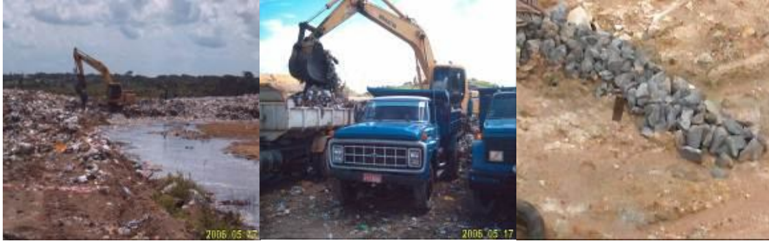
Figura 6. Recuperação das trincheiras. Fonte: Carvalho, F.H.(2011).
