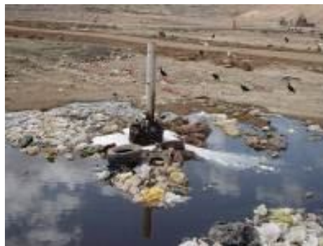
Figura 2. Nível do piezômetro na trincheira T2 e vazamento no pé do talude. Fonte: Carvalho Jr, F.H.(2011).
