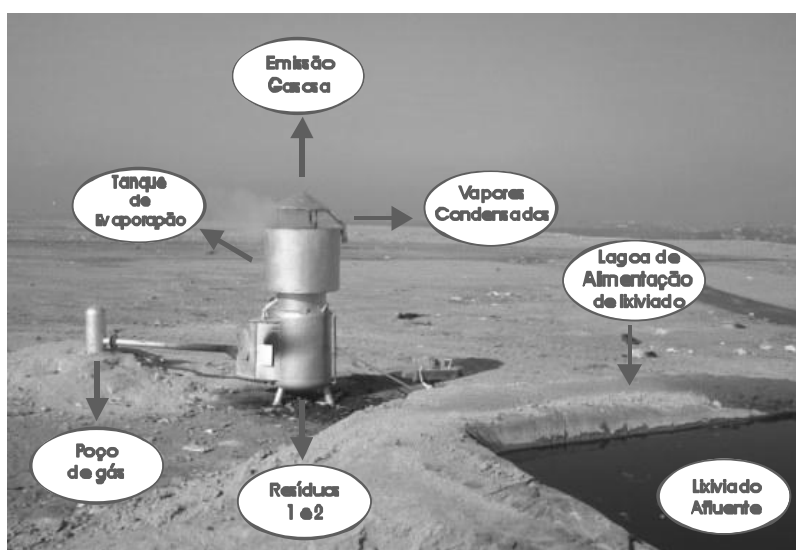
Figura 1. Evaporador Unitário em funcionamento no aterro
