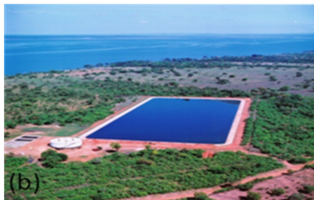
Figura 2. ETE Vila União, estado do Tocantins, Brasil: (a) Reator UASB e (b) Lagoa Facultativa
