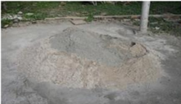
Foto 3. Preparo da massa para sentar tijolos
