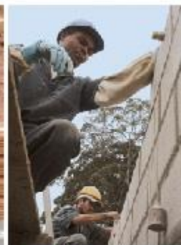
Foto 6. Utilização do prumo na parede
