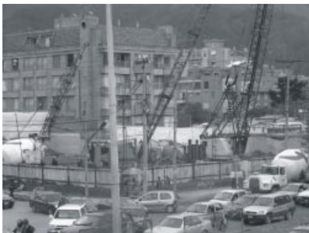
Figura 1. Autopista Norte con Calle 99, demolición de dos casas y construcción de un nuevo edificio en el sector de Chicó
