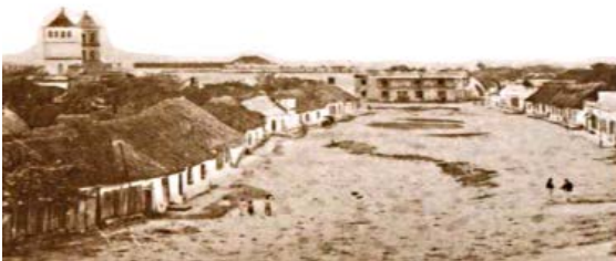
Imagen 7. “Fotografía de la Antigua Calle Ancha de Barranquilla” (1880) 33
