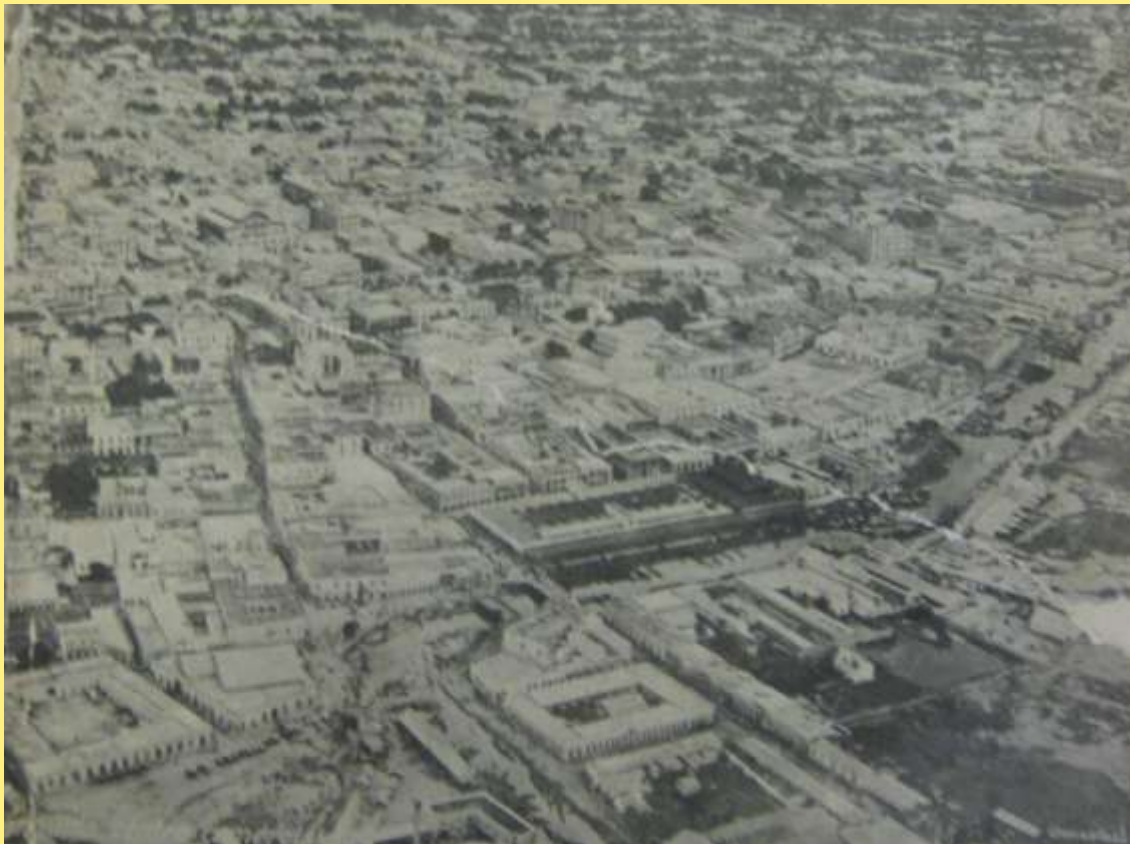
Foto 1. Barranquilla. Fotografía aérea de la Scatda del año 1932
