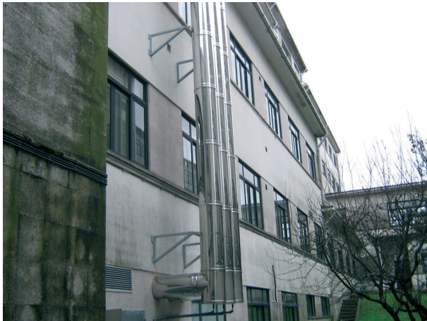
Nuevas chimeneas instaladas sobre la fachada.
