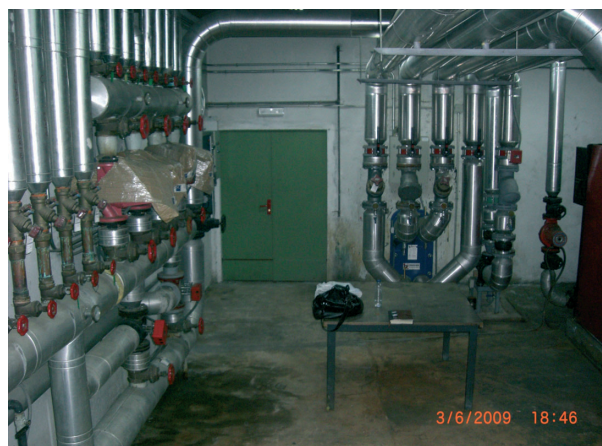
Se puede apreciar que la Sala de Calderas funcionaba como entrada al C.T., ubicado detrás de la puerta verde.
