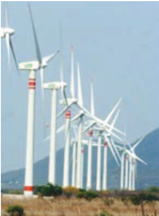
Figura. 1. Aerogeneradores en el parque eólico de la Venta II.
