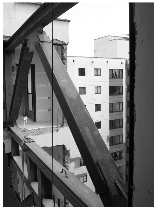
Figura 7. Arriostramiento metálico instalado en la fachada posterior de la edificación.
