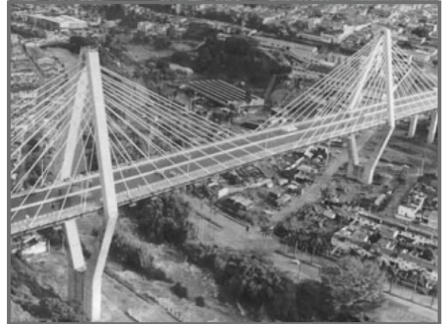
Figura 3. Viaducto Pereira - Dos Quebradas
