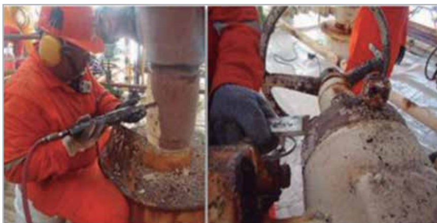
Figura 6. Operaciones de limpieza, plataforma Marsopa.
