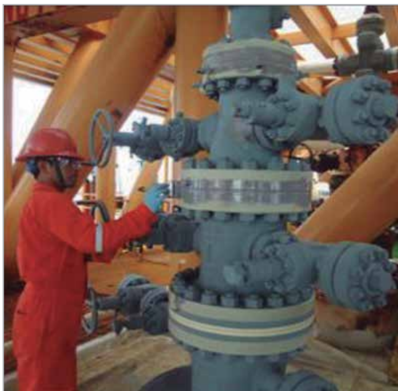
Figura 8. Rehabilitación de árbol de válvulas. Plataforma Marsopa.
