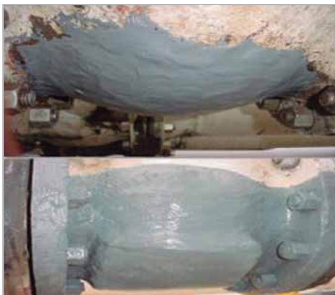
Figura 7. Rehabilitación de válvulas laterales del ½ árbol. Plataforma Marsopa.
