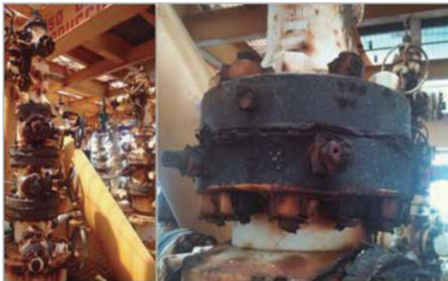
Figura 4. Condiciones del ½ árbol de válvulas tipo “solid block”.
