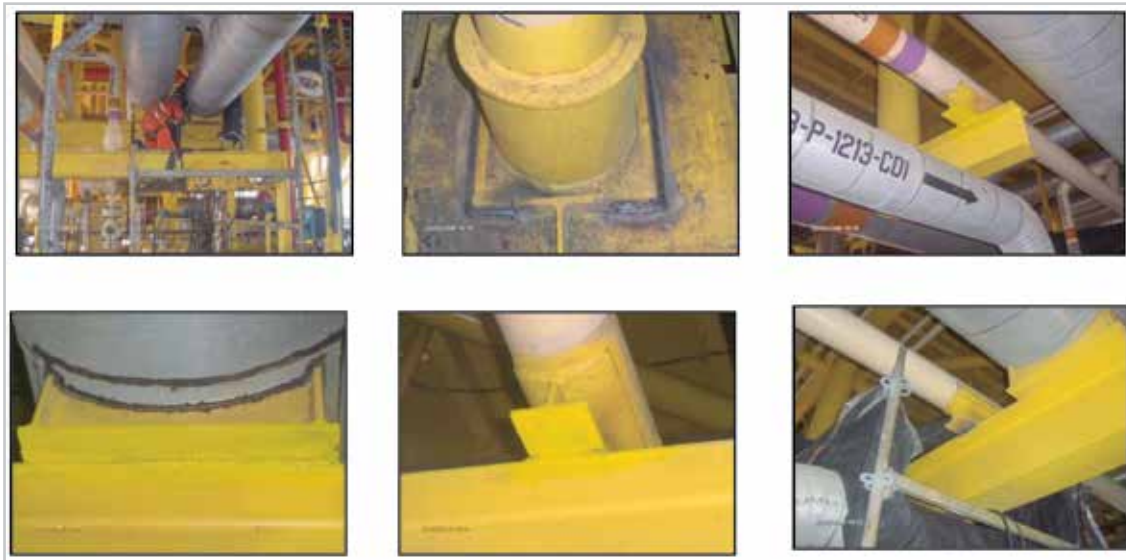
Figura 10. Fotos de soportería instalada en tuberías en PB-Zaap-C.
