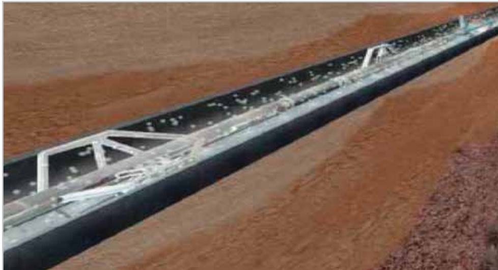
Figura 2. Sarta de PLT bajado con tractor.
