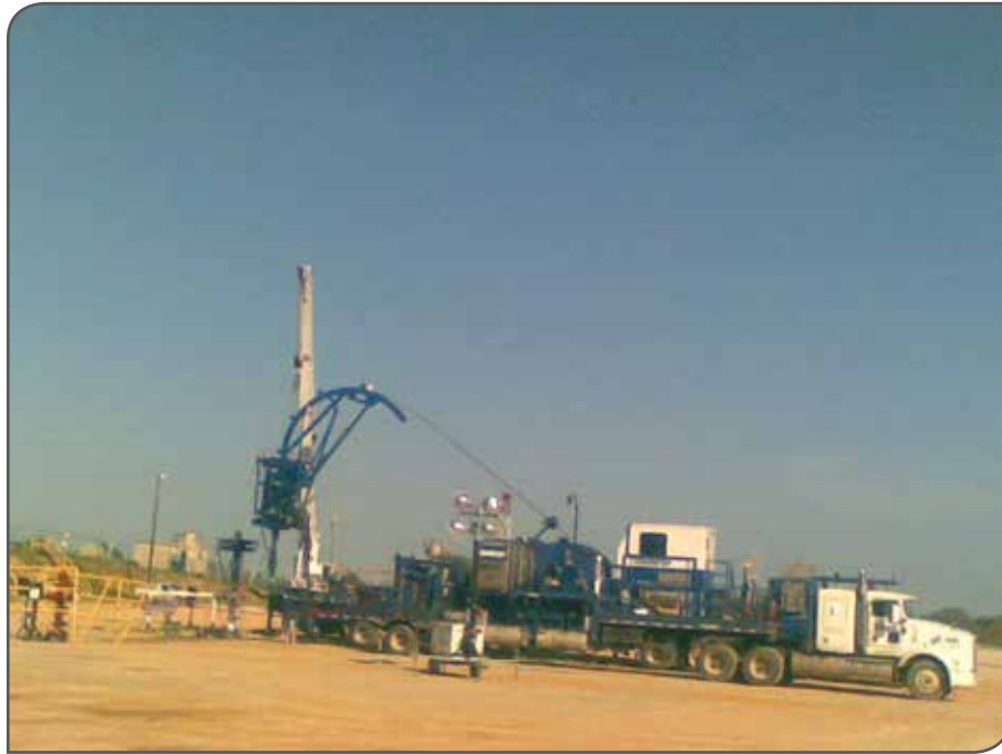
Figura 13. Instalación de TF dentro de TP pozo Rabasa 142.
