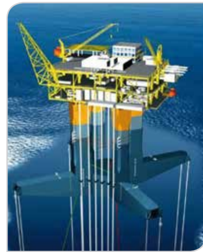
Figura 13. Plataforma TLP o Tension Leg Platform o plataforma de patas tensionadas.
