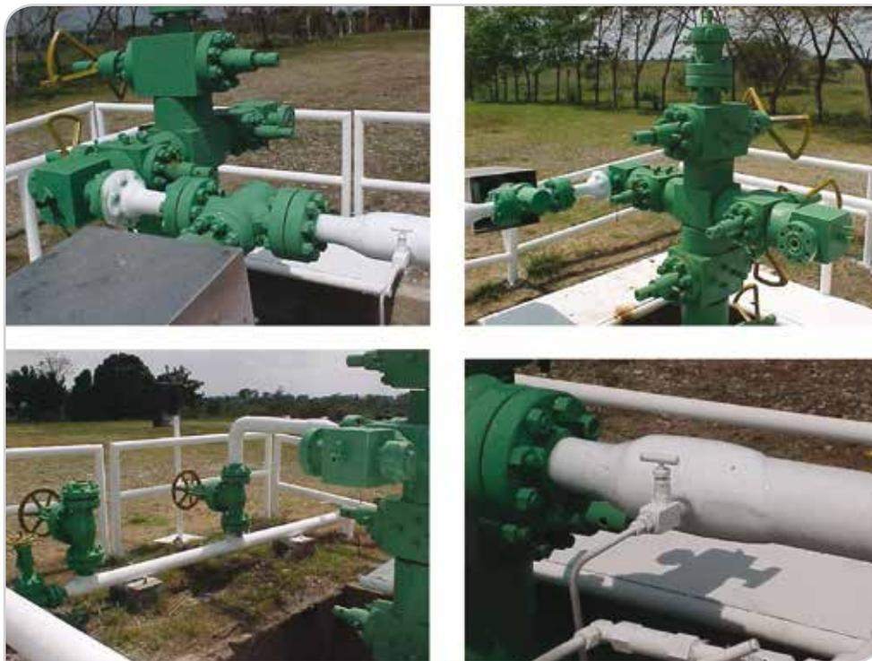
**Figura 9.** Congelamiento en estrangulador superficial, bajante del pozo, conexiones y línea de descarga.
