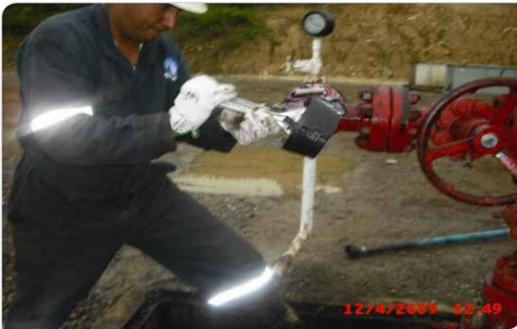
Figura 19. Concluyen trabajos en el pozo Agua Fría-654.
