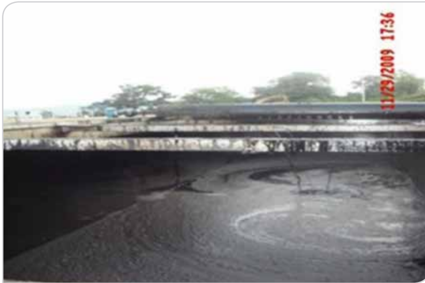
Figura 16. Aportando fluidos a presa metálica.
