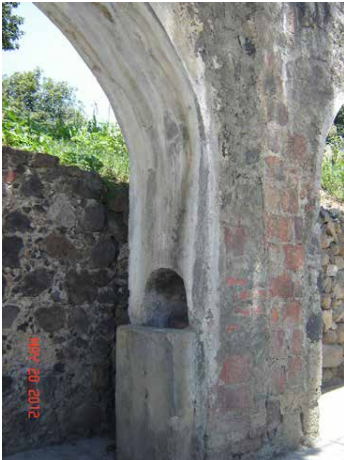
Figura 12. Pila en el acueducto "Los arcos"
