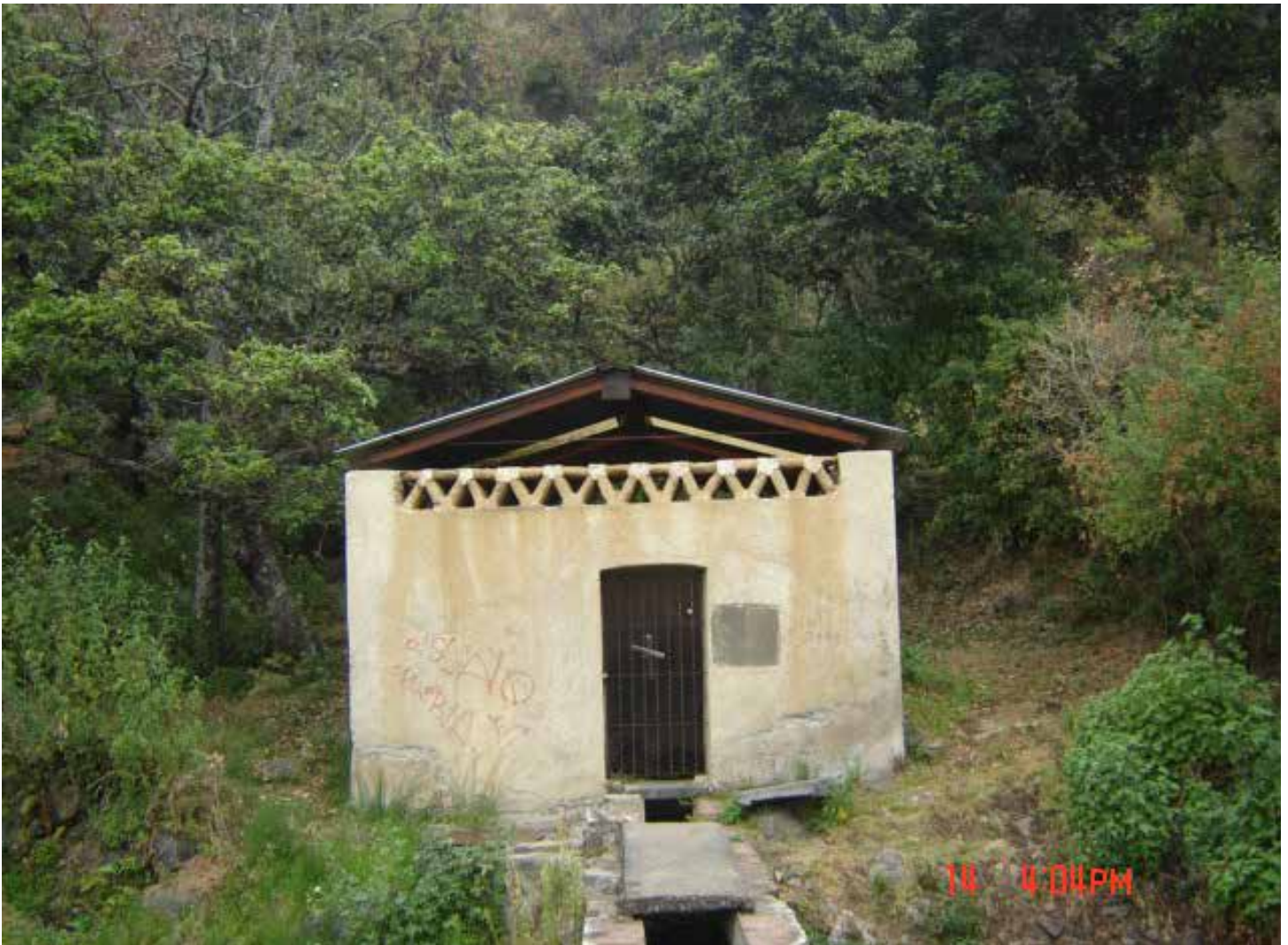
Figura 7. Fachada Principal de la caja almacenadora como sistema de captación del agua del ojo "del Arco".
