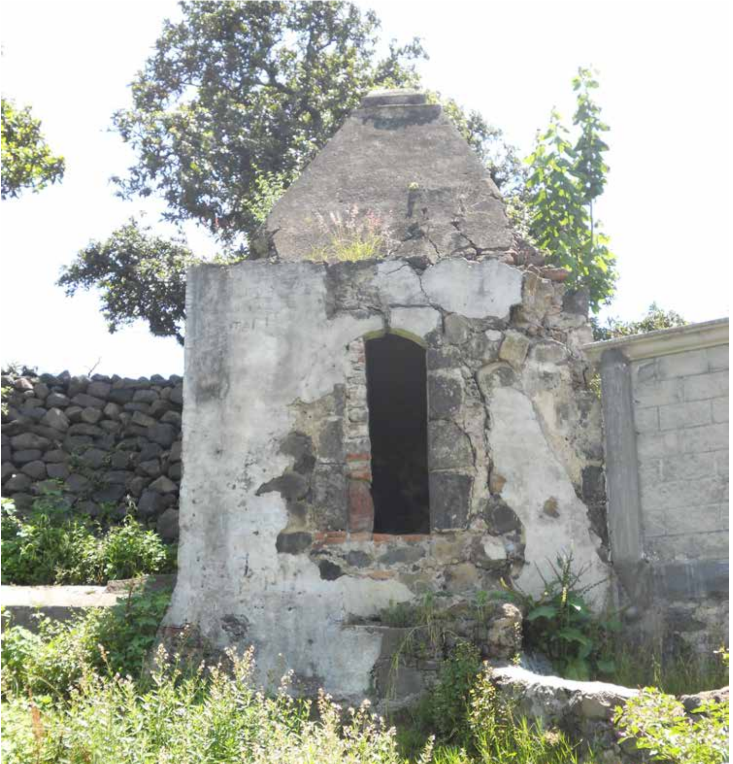
Figura 11. Fachada principal de la caja repartidora 1.
