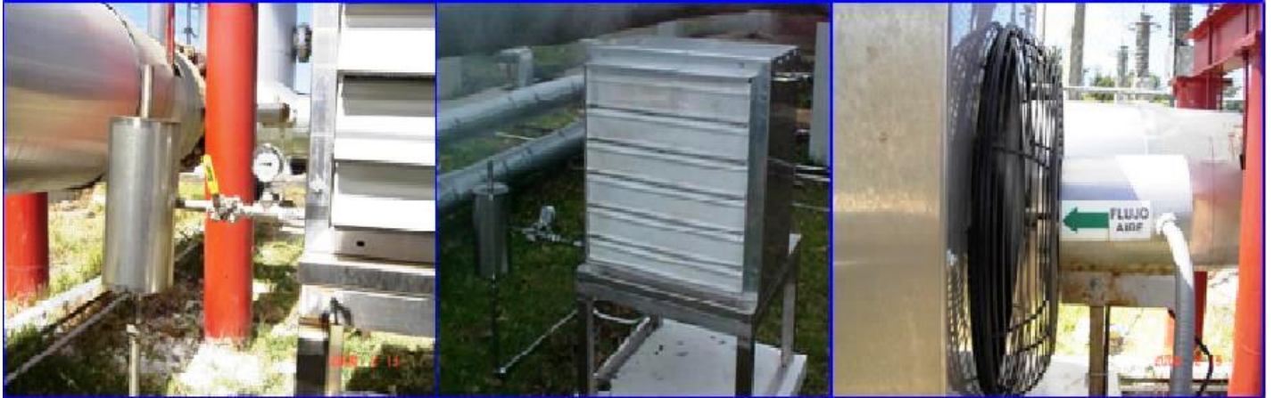
Fig. 3. Condensador de vapor enfriado por aire.
