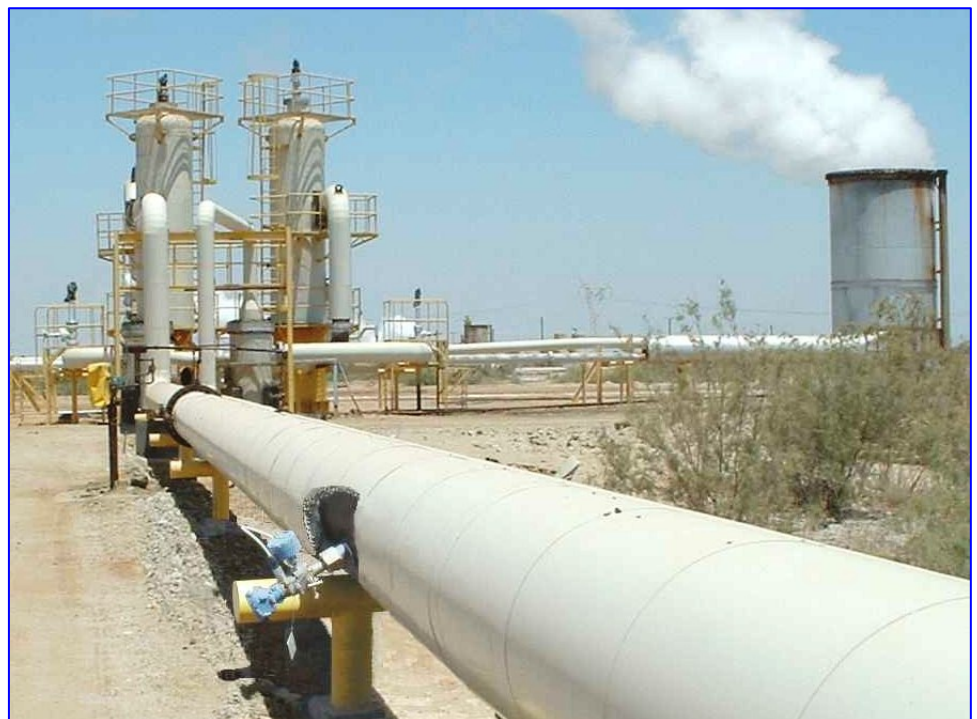
Foto 3. Sistema de regulación entre separadores de alta y baja presión.
