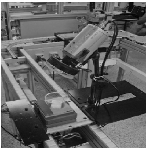
Figura 4. Estación de supervisión para el control de calidad
