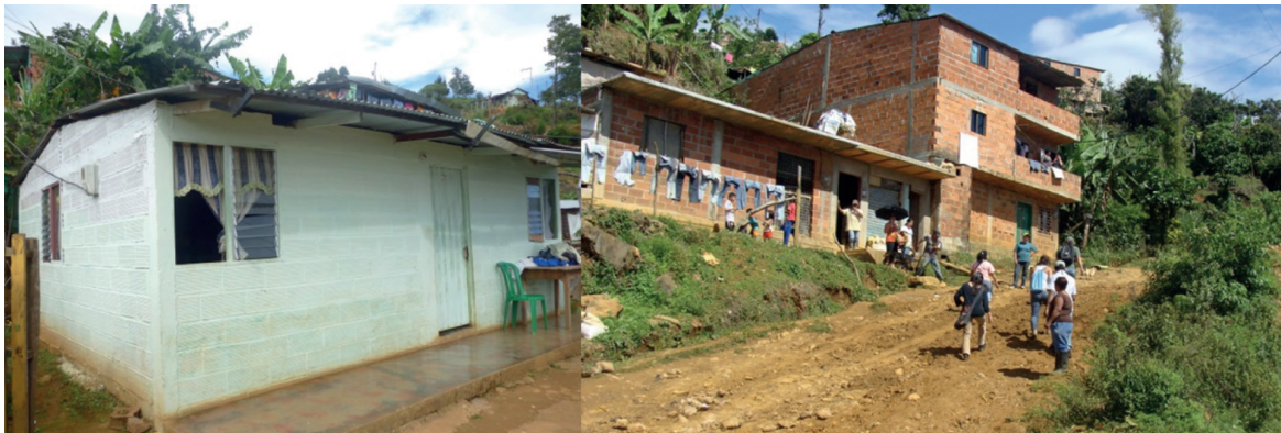
Foto 4. Estado de algunas viviendas
