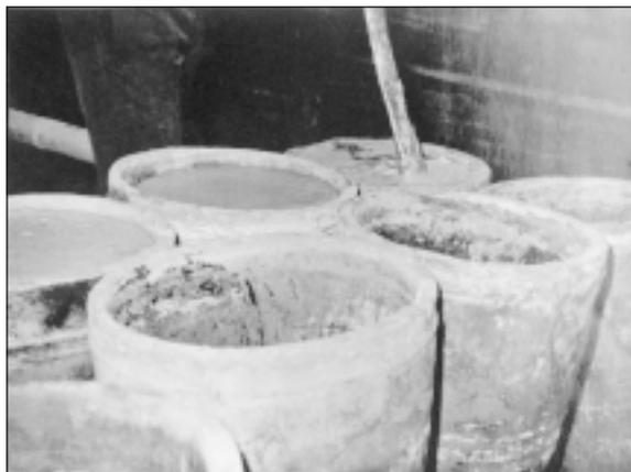
A medida que se llenan las hormas, éstas se trasladan a un edificio ubicado aparte de las hornillas, llamado sala, casa o salón de purga, donde otro armazón de madera (el “tendal”) sostiene las vasijas (fotografía 4). Después de dos o tres días de reposo, se destapa el orificio inferior, por donde escurre la miel de purga, que puede servir para fabricar aguardientes o la alimentación del ganado.
