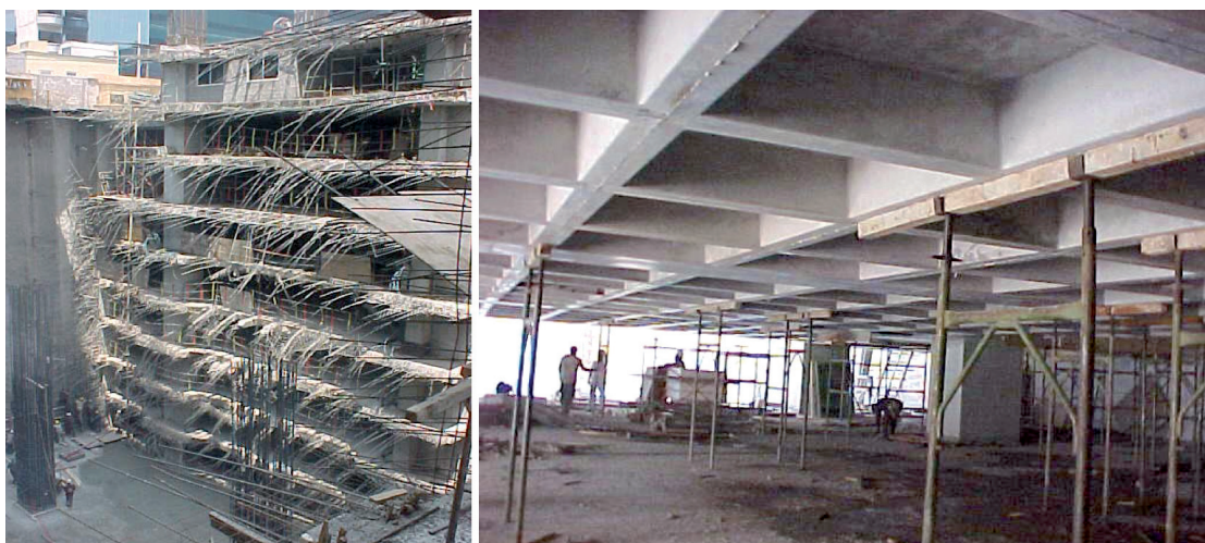
Fig. 1. Losas postensadas reticulares o encasetonadas en sótanos.
