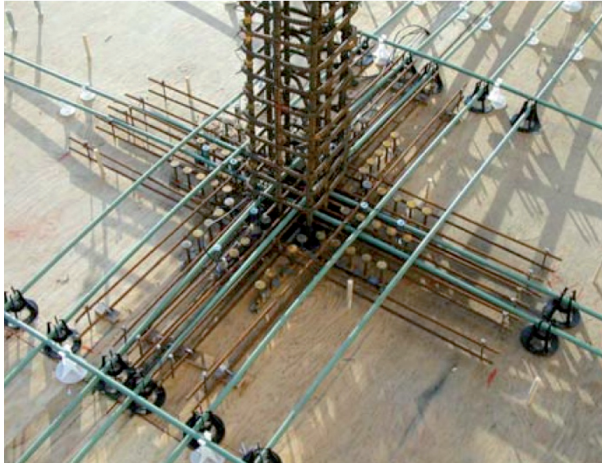
Fig. 9. Conexión interior reforzada con SSR (Kang, 2004).
