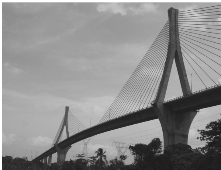
Fig. 1. Vista del puente Antonio Dovalí Jaime.
