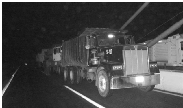
Fig. 6. Camiones cargados ubicados en el puente durante las pruebas de carga.
