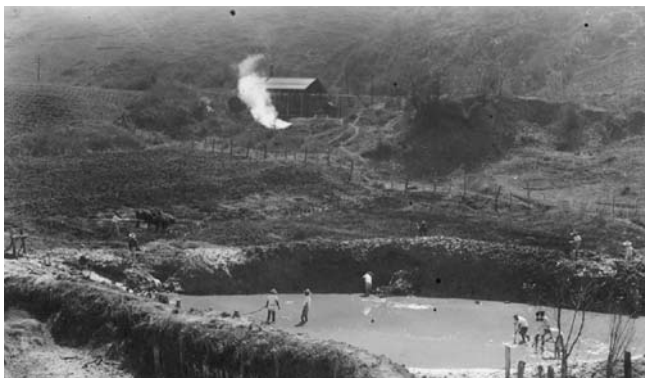
Presa de tierra donde nacen los manantiales. Al fondo la estación de bombeo, se observa una pequeña caseta en donde se encuentra el pozo que perjudica las afloraciones de los manantiales, 1930, Cárdenas, San Luis Potosí. AHA, Aprovechamientos Superficiales, caja 278, expediente 6701.
