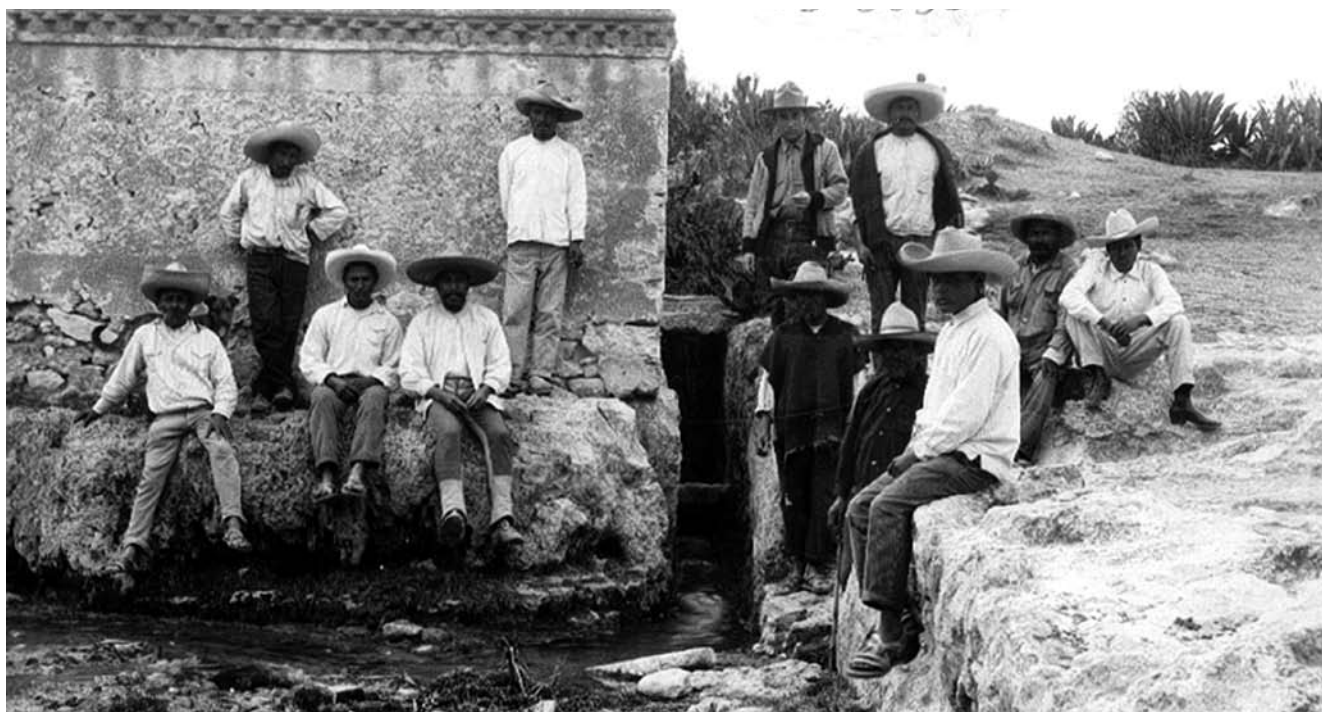
Canal con agua del Jagüey de Arriba, que riega terrenos del barrio de San Juan Acatzingo, 1931, Acatzingo, Puebla. AHA, Aprovechamientos Superficiales, caja 959, expediente 13561, f. 11.
