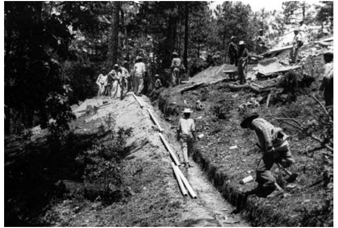
Excavación de cepas para la línea de conducción de agua potable, por cuenta de los interesados, 1982, Latuvi, Oaxaca. AHA, Comisión del Papaloapan, caja 340, expediente 5646.
