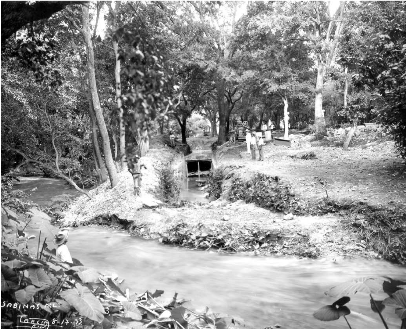
Obras para derivar agua del manantial de Sabinas y generar electricidad para uso de un molino de maíz, trigo y soya, propiedad de Manuel M. García, 1933, Sabinas, Nuevo León. AHA, Aprovechamientos Superficiales, caja 4177, expediente 56480, inventario AS-25-25463.
