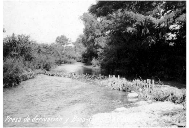
Presa y bocatomina de la acequia de La Ciudad derivando agua del río Montemorelos para riego de huertos de naranjos, 1923, Montemorelos, Nuevo León. AHA, Aprovechamientos Superficiales, caja 1407, expediente 19239, inventario AS-06-6030.
