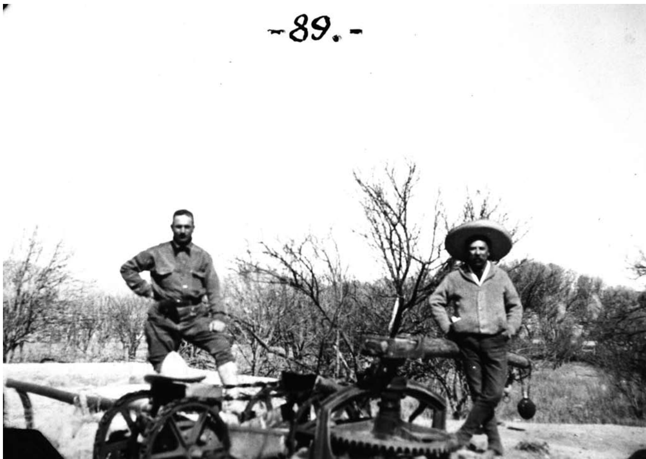
Noria instalada en el pozo de la huerta de la hacienda de San Juan de la Vaquería, 1928, Saltillo, Coahuila. AHA, Aprovechamientos Superficiales, caja 4348, expediente 57673, inventario AS-26-26520.
