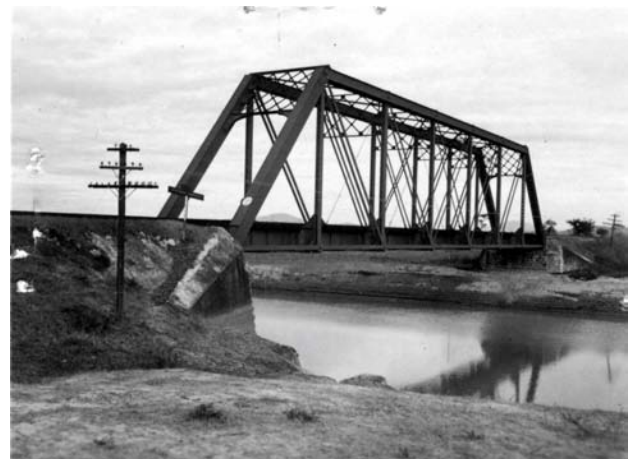
"Puente de Salamea sobre el río Lerma, vista general", 1942, Jalisco, AHA, Consultivo Técnico, c. 360, exp. 3114.
