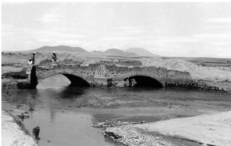
"Detalle del puente de San José Pathé. Trabajos de desazolve en la margen derecha del Río Lerma", 1959, San José Pathé, Estado de México, AHA, Aprovechamientos Superficiales, c. 2658, exp. 37271.
