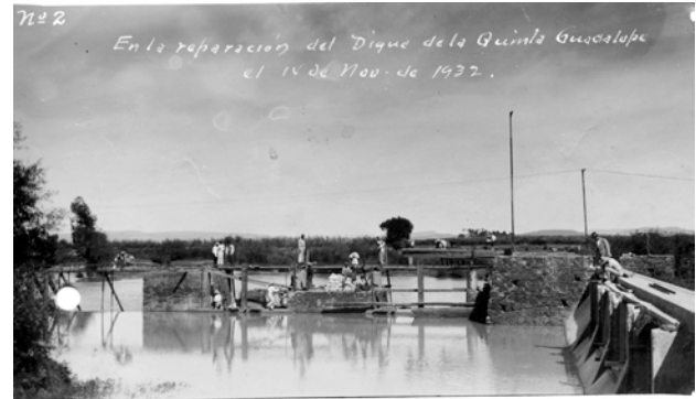
"Reparación del Dique de la Quinta Guadalupe", 1932, La Piedad, Michoacán, AHA, Aprovechamientos Superficiales, c. 4166, exp. 56392.
