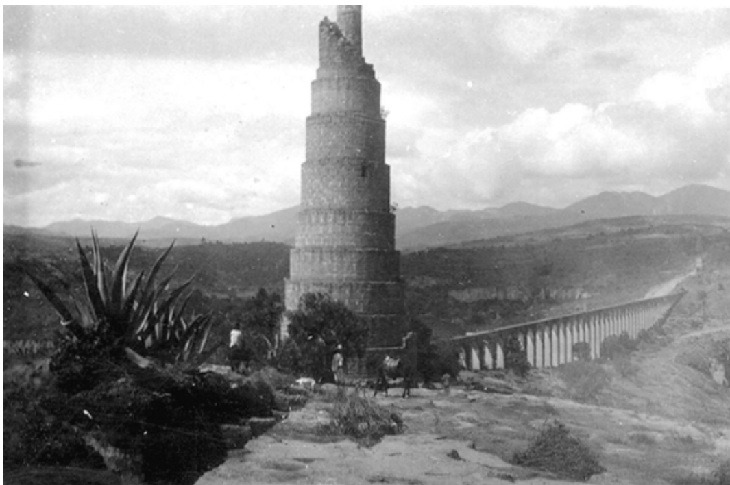
"Acueducto soportado por una gran alquería y uno de los torreones extremos de dicho acueducto", 1926, Hacienda de Echegaray, San Bartolo Naucalpan, Estado de México, AHA, Aprovechamientos Superficiales, c. 595, exp. 8693.
