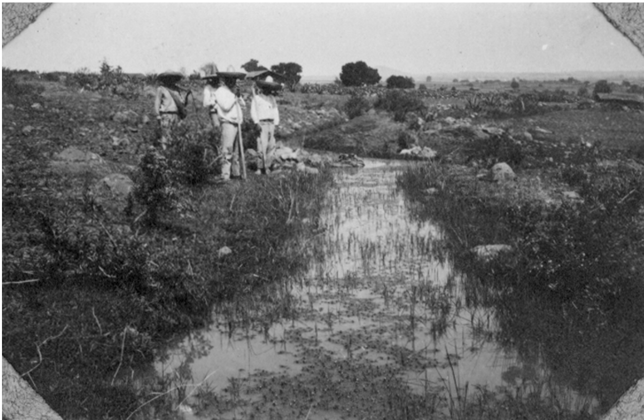
"Trabajos de inspección en el Canal Zanja del Gobierno", 1922, Jilotepec, Estado de México, AHA, Aprovechamientos Superficiales, c. 351, exp. 7242.
