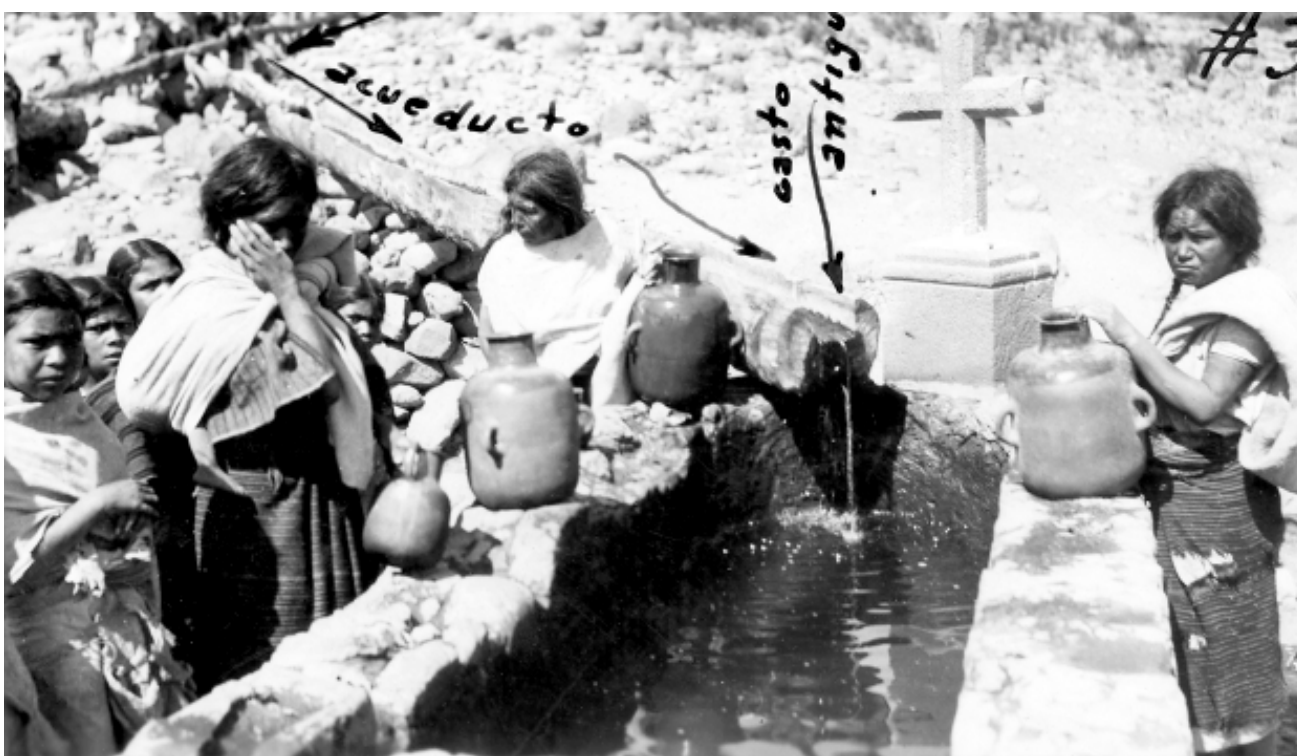
"Mujeres tomando agua del manantial el Meje, en donde se nota canaletes de madera hendidos en troncos de árbol", 1939, Pueblo Nuevo, Atlacomulco, Estado de México, AHA, Aprovechamientos Superficiales, c. 2050, exp. 30993.
