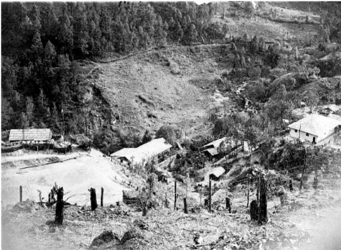
"Vista general de las instalaciones de la planta hidroeléctrica", 1931, Villa Madero, Michoacán, AHA, Aprovechamientos Superficiales, c. 1181, exp. 16483.
