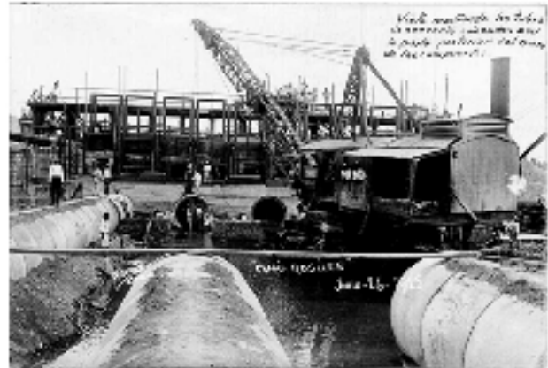
"Obreros trabajando en la instalación de los 5 tubos de concreto en las compuertas de la bocatoma del canal rosales, los cuales servirán para conducir las aguas del río al canal principal", 1922, Culiacán, Sinaloa, AHA, Aprovechamientos Superficiales, c. 522, exp. 8064.
