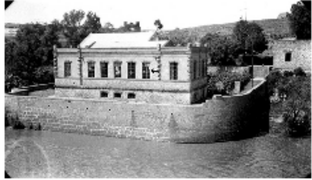
"planta hidroeléctrica abandonada, la cual aprovechaba las aguas de la presa de echeverría", 1926, Cholula, Puebla, AHA, Aprovechamientos Superficiales , c. 929, exp. 13186.
