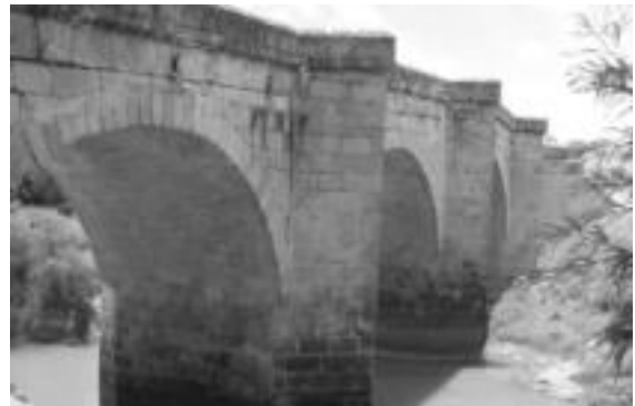
Vista del Puente de Acámbaro, Guanajuato, desde el noroeste. Fotografía de Guillermo Boils.
