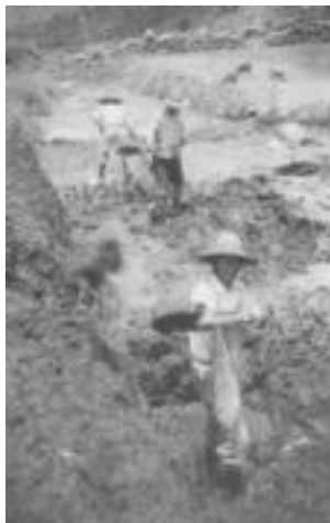
“Hombres trabajando en la limpia de canales”, 1941, Zacapu, Michoacán, AHA, Aprovechamientos Superficiales, c. 3669, exp. 50935.
