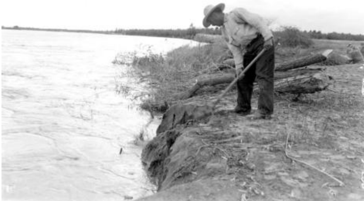
“Una vista hacia aguas abajo a lo largo de la defensa en curso de construcción, kilómetro 49. Este ataque está ubicado cerca de un kilómetro aguas arriba del cruce del ferrocarril”, 1941, Distrito de riego del río Colorado, Baja California, AHA, Aprovechamientos Superficiales, c. 3062, exp. 42323.
