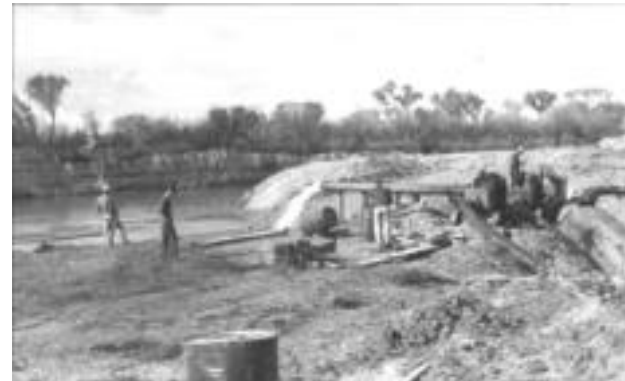
“Bombas para desaguar el recinto de trabajo de la presa del Alamo. Al fondo el canal de desviación”, 1941, Distrito de riego del río Colorado, Baja California, AHA, Aprovechamientos Superficiales, c. 3062, exp. 42323.
