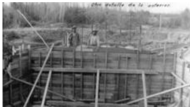
“Otro detalle de los tubos de desagüe instalándose en el punto de liga del Borde del Gobierno Americano con el de la Colorado River Land Company, dentro del territorio de los Estados Unidos”, 1928, Baja California, AHA, Aprovechamientos Superficiales, c. 1033, exp. 14534.
