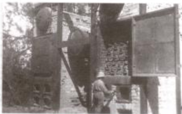
"Hombre inspeccionando las calderas y motores de Leobardo Salido", 1933, Navojoa, Sonora, AHA, Aprovechamientos Superficiales, c. 209, exp. 5047.
