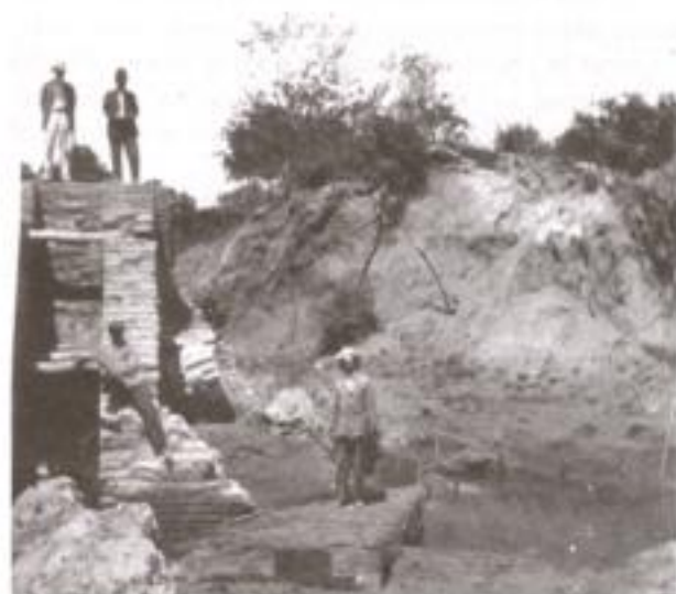
"Hombres situados sobre la Bocatoma", 1919, Ahome, Sinaloa, AHA, Aprovechamientos Superficiales, c. 152, exp. 3615.
