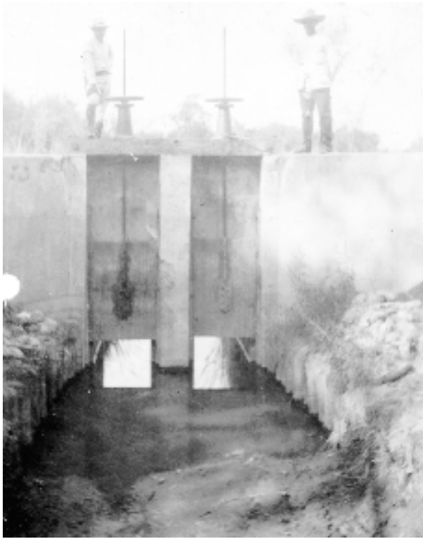
“Hombres sobre la Bocatoma de la Hacienda el Limón”, 1923, Ciudad Valles, San Luis Potosí, AHA, Aprovechamientos Superficiales, c. 144, exp. 3344
