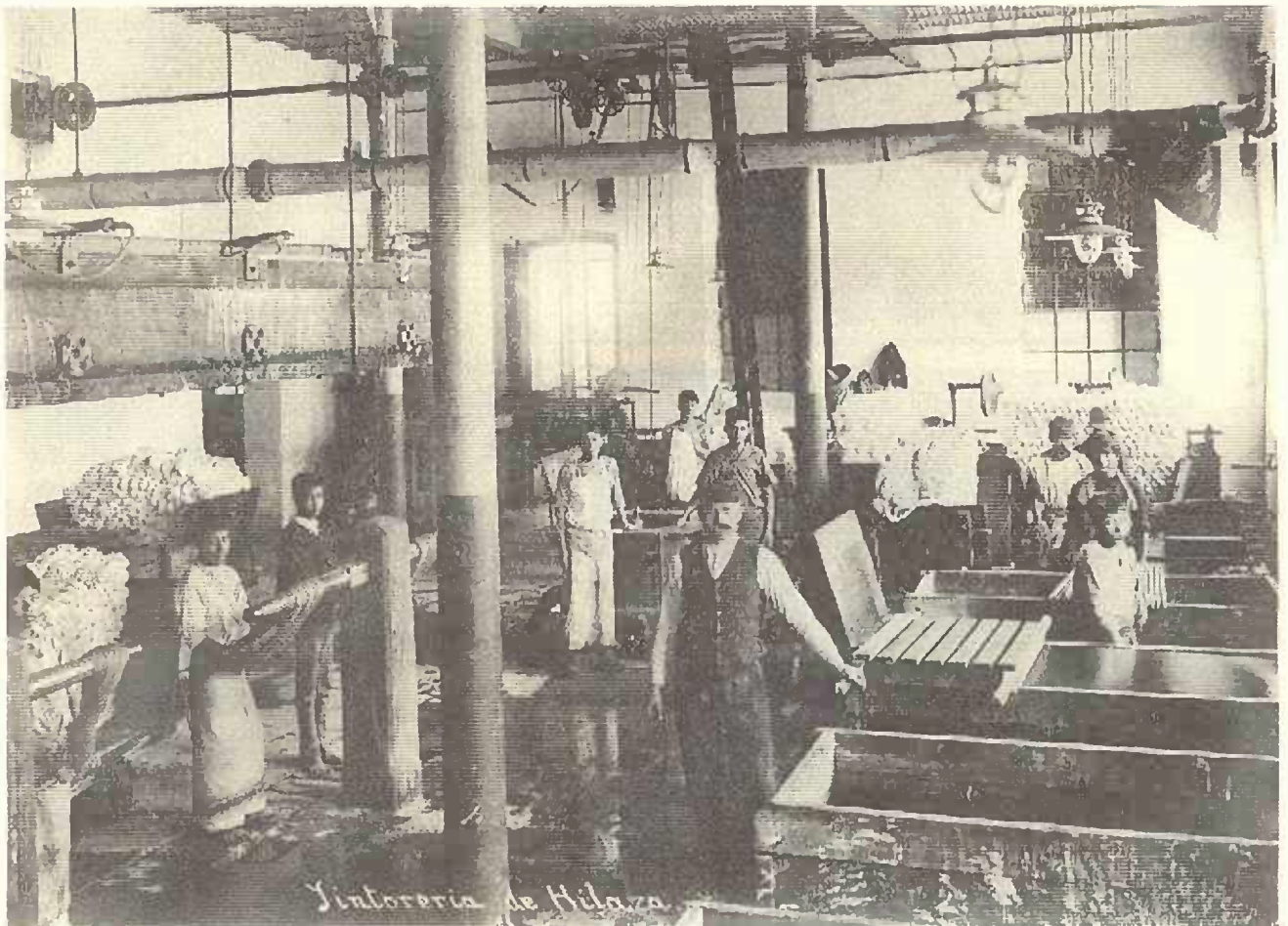
"Tintorería de Hilaza", 1917, Compañía Industrial de Atlixco, Puebla. Archivo Histórico del Agua. Aprovechamientos Superficiales, caja 4209, expediente 56695.
